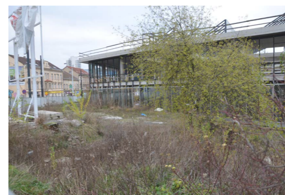
Rozestavěná budova nového úřadu MČ P8
