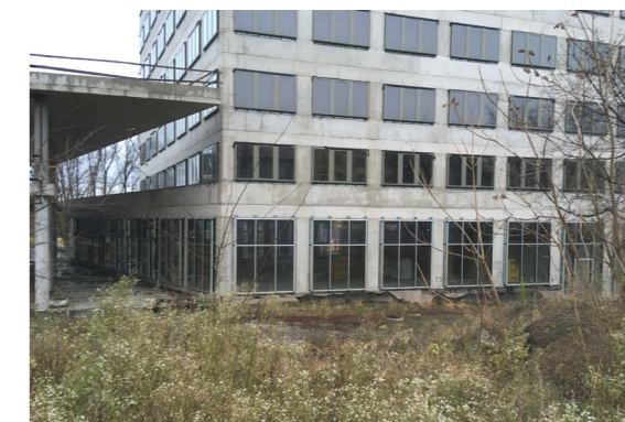
Rozestavěná budova nového úřadu MČ P8
